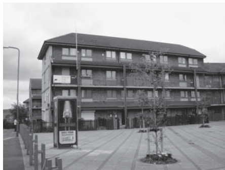
図11 バーングリーブネットの無線LANのアクセスポイント(建物左上のアンテナ)
