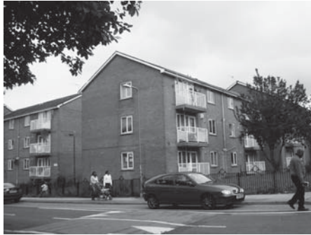
図12 バーングリーンネットの活動拠点 (写真中央の建物の一階の部屋)
